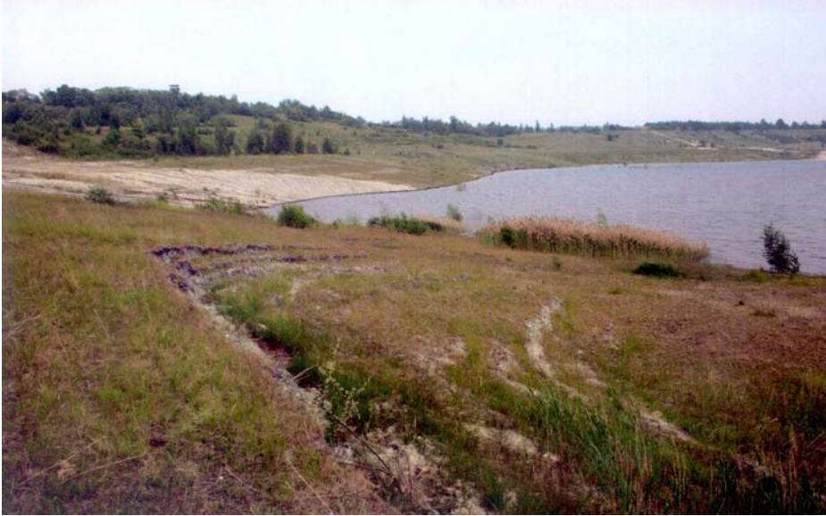
Abb.3 Böschungsdeformation Mueheln (Westböschung), Blickrichtung Nord
