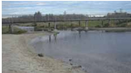
Abb. 7: Einschnürung des Abflussquerschnittes der Auslaufbucht Cospuden in Höhe der Fußgängerbrücke
