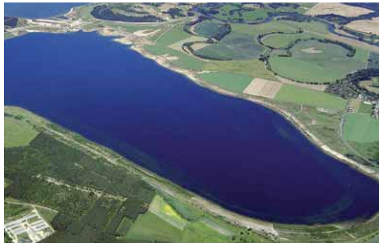
Abb. 15: Luftbildaufnahme Seelhauser See mit durch Hochwasserüberlauf erodierten Nordufer (Buchtenbereich)
