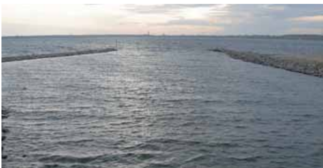
Abb. 12: Auslaufbucht Cospuden, Blick auf den Einlaufbereich ca. ein Jahr nach Fertigstellung
