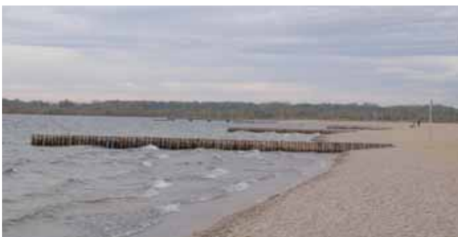
Abb. 14.: Hakenbuhnen zur Stabilisierung des Badebereiches Nordstrand Cospuden
