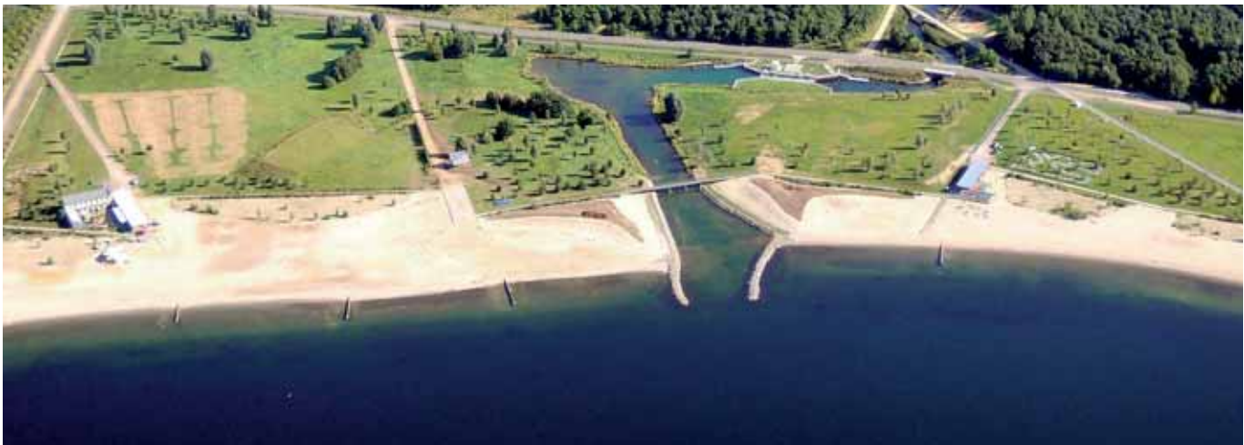
Abb. 11: Auslaufbucht Cospuden, direkt nach Fertigstellung der Bauwerke
