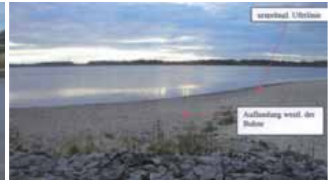
Abb. 8: Anlandung von Sedimentmaterial im Luv der Buhne am Westufer der Auslaufbucht Cospuden
