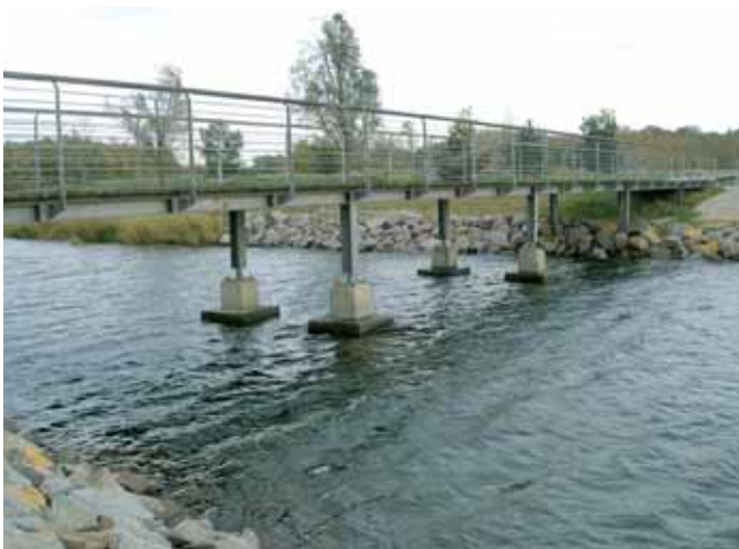
Abb. 13: Auslaufbucht Cospuden, Blick auf den Bereich der Fußgängerbrücke
