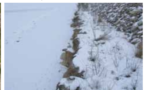
Abb. 7: Kliffufer vor der Steinschüttung mit Blickrichtung Nord bei Frost Anfang des Jahres 2012, mit fortschreitendem Abbruch
