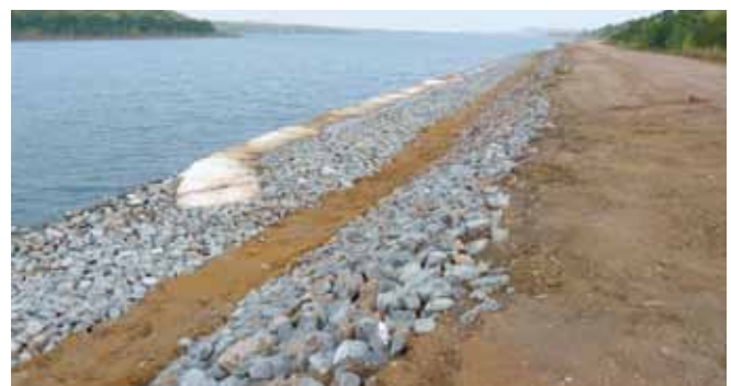
Abb. 17: Böschungsbefestigung mit Substratauffüllung im Unterwasserbereich des Endwasserspiegels
