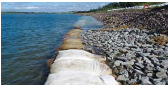
Abb. 16: Fertigstellung der Überdeckung der Sandmatten in unterschiedlichen Arbeitsstufen entlang des Ufers
