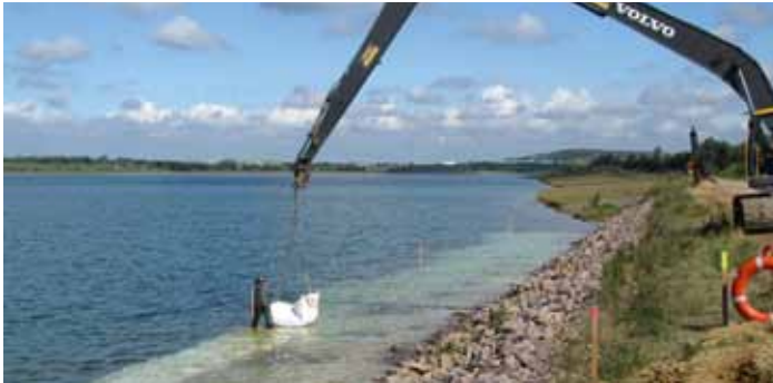
Abb. 14: Einbau der Sandcontainer auf die mit Sandmatten überdeckte Unterwasserböschung
