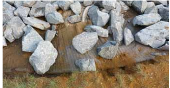
Abb. 15: Mit Steinen beschwerte Sandmatte im Anschluss an die bestehende Böschungsbefestigung
