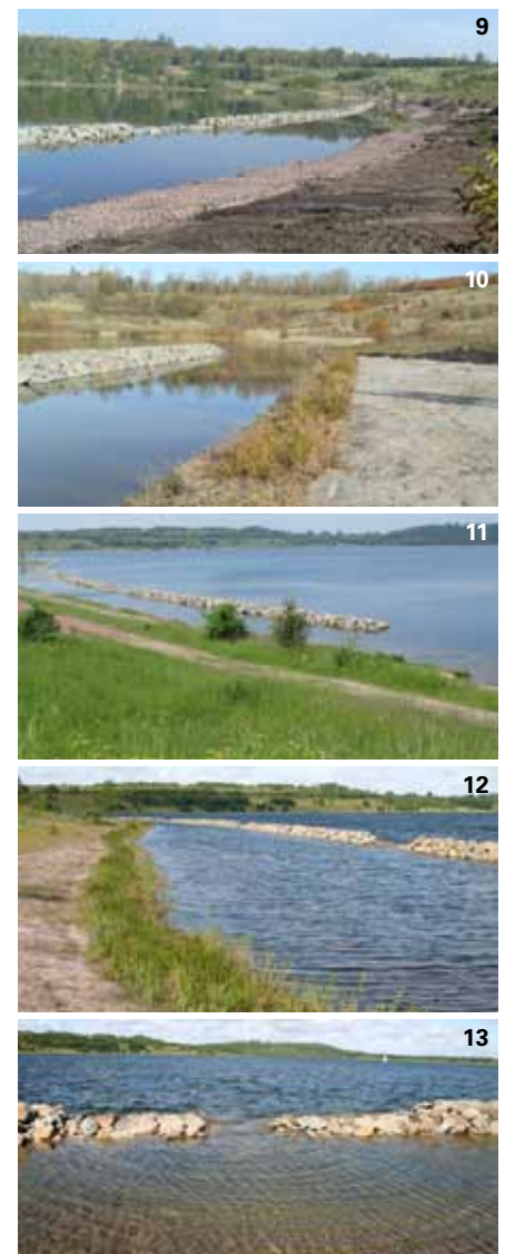
Abb. 9: Bauzustand des Wellenbrechers
