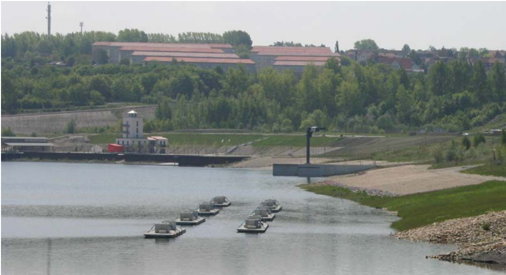
Abb. 6 Anordnung der Wellenbrecher als gestaffelte Einheit
