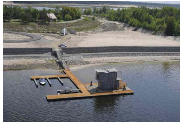
Abb.12 Schwimmendes Haus (Ausgangszustand)
