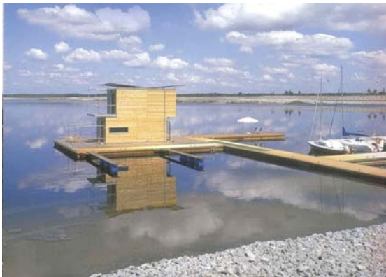
Abb. 11 Schwimmendes Haus (Ausgangszustand)
