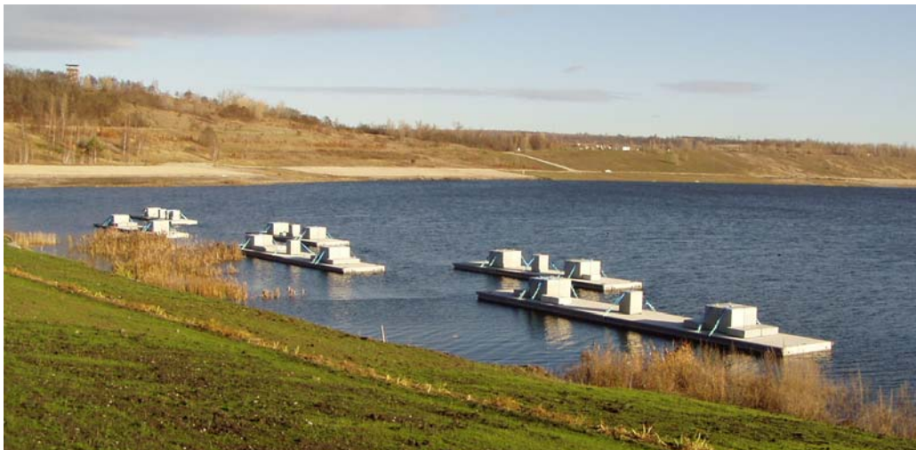
Abb. 7 Wellenbrecher im Einsatz vor dem gefährdeten Böschungsabschnitt
