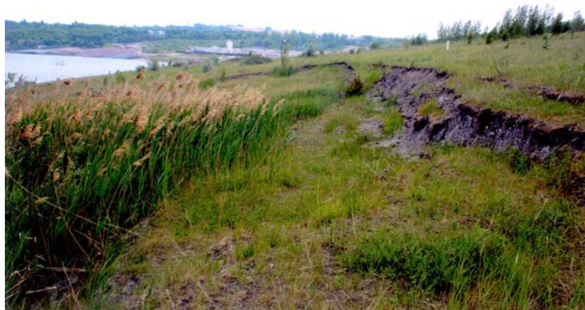
Abb. 2 Böschungsdeformation Mueheln (Westböschung), Blickrichtung Süd
