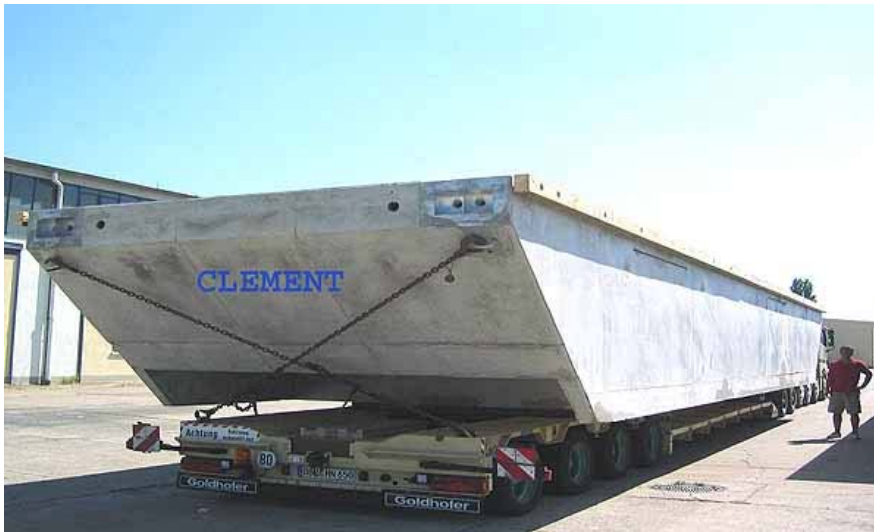
Abb.5 Grundkörper eines Stegelementes beim Transport
