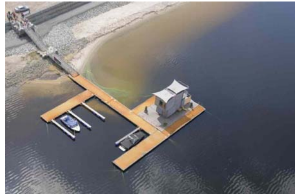
Abb.14 deutlich sichtbarer Sandeintrag
